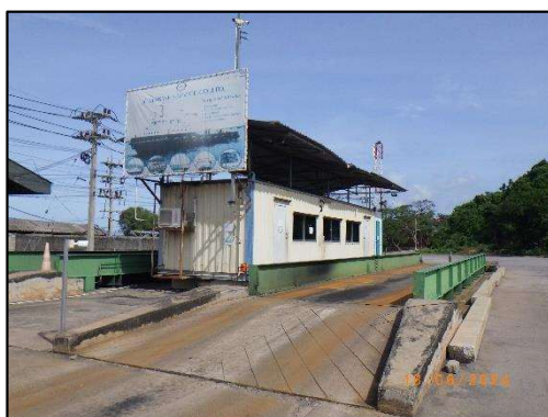
ห้องสูบน้ำหนักรถบรรทุกของโครงการ
